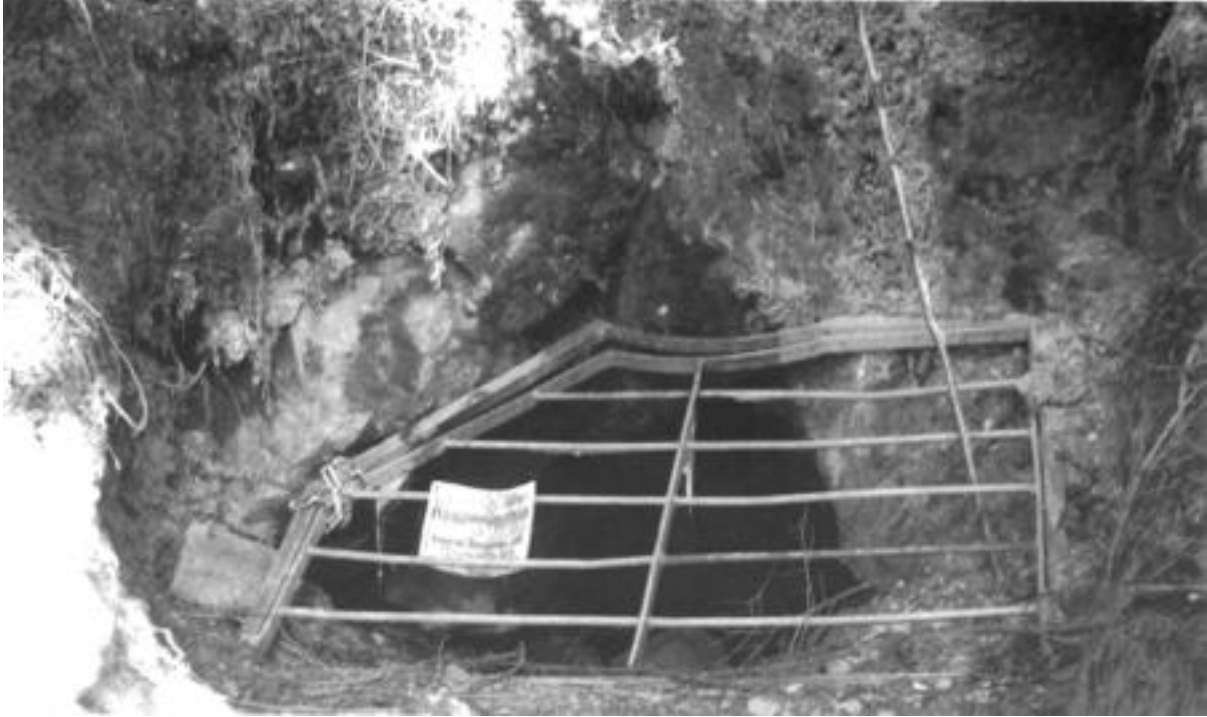
Vergitterter Stollen am Radweg.
